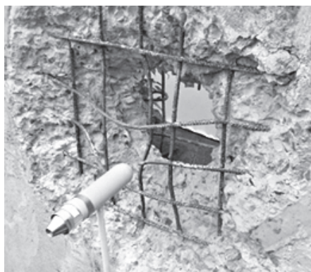
Рис. Разрушение железобетонной плиты многоцелевым снарядом 40-мм пушки СТWS-40
