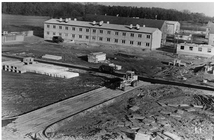
Рис. 7. Строительство завода по ремонту средств связи
